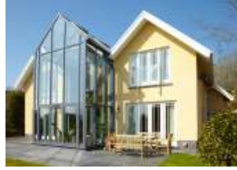
صورة (1) منزل متطور بإضافة هيكل من المعدن والزجاج للمبنى الأصلي والذي يسمح بمساحة إضافية لغرفة المعيشة
